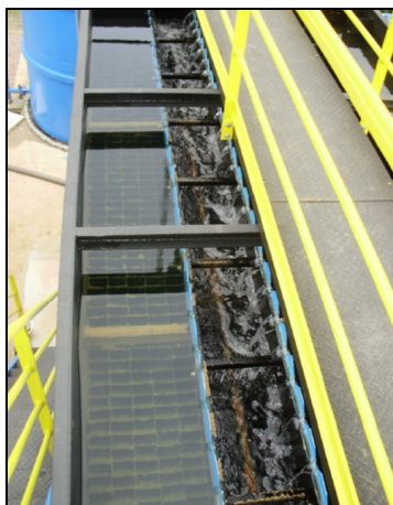
Fotografia 2 – Plataforma de acesso Fonte: Autora (2016)
