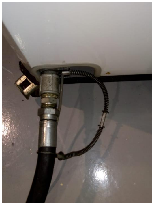
Figura 5 - Molas de segurança para mangueiras pressurizadas. Fonte: a autora, 2019
