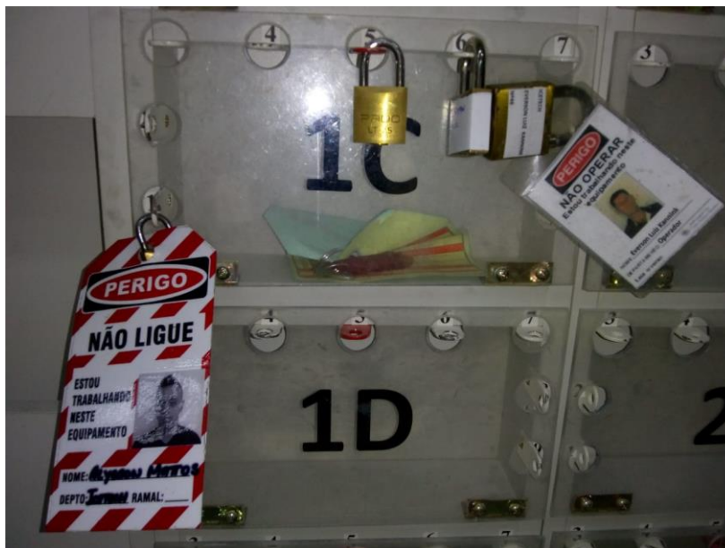
Figura 3 - Cadeados identificados individualmente para bloqueio de acionamento. Fonte: a autora, 2019
