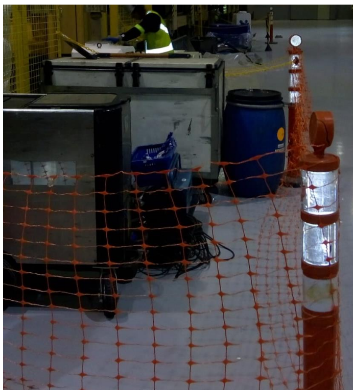
Figura 4 - Isolamento da área de realização da atividade. Fonte: a autora, 2019
