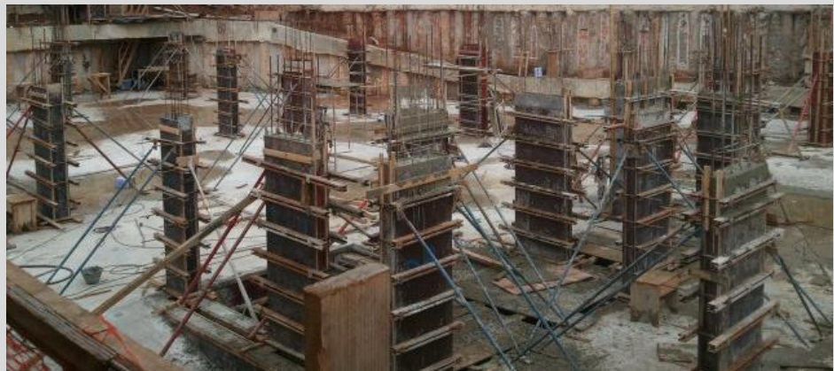
Figura 3 – Armações de pilares escorados e apoiados. Fonte: Autoria própria, 2017.
