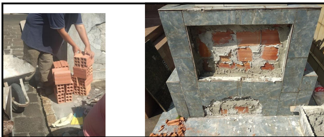
Figura 10 – Fechamento da sepultura em alvenaria. Fonte: Autoria Própria.
