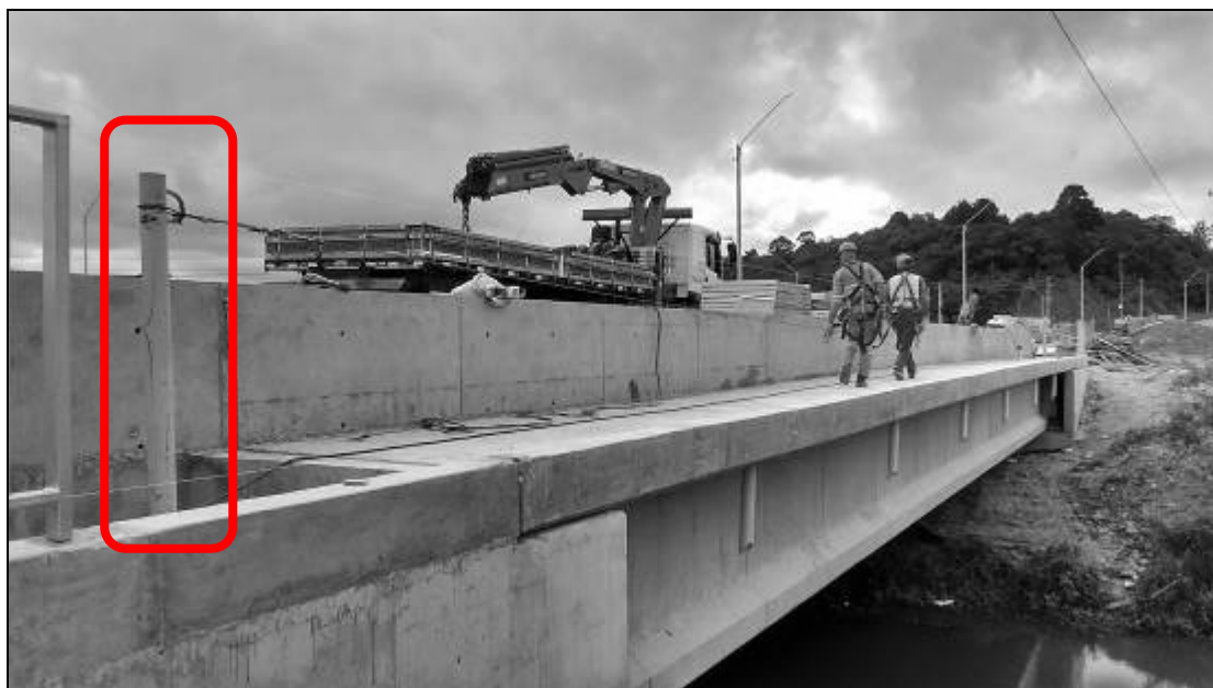
Figura 26 – Detalhe ponto de ancoragem e linha de vida horizontal Fonte: O autor, 2017
