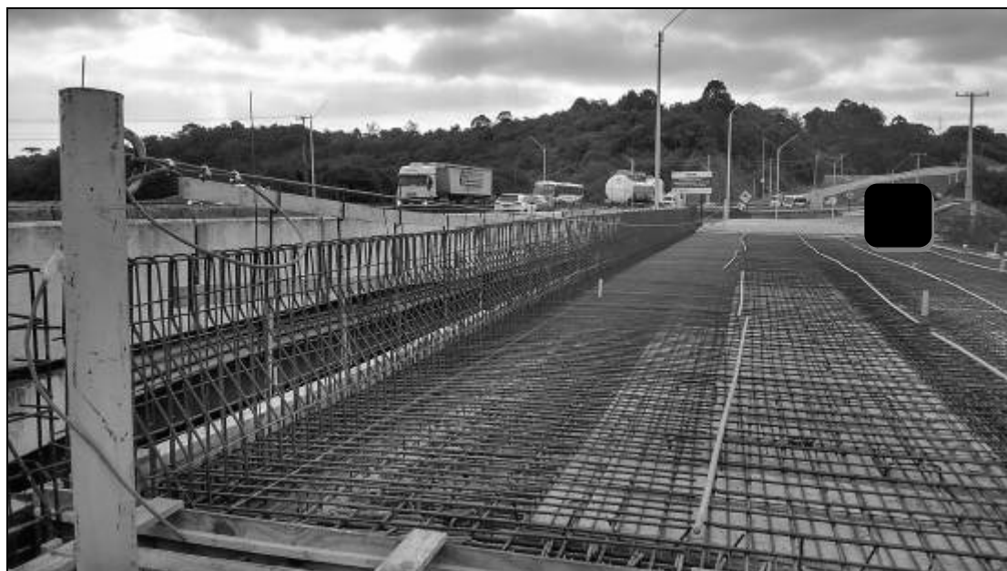
Figura 28 – Detalhe ponto de ancoragem e linha de vida horizontal Fonte: O autor, 2017
