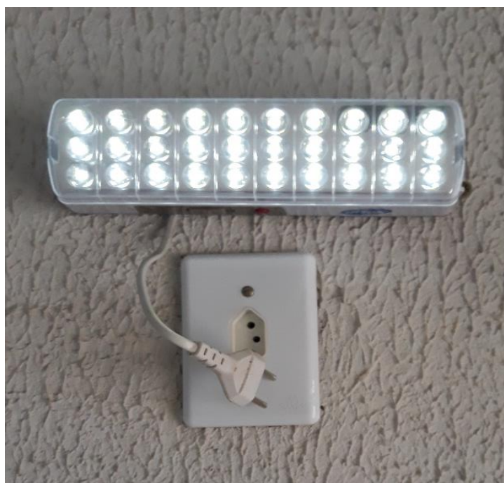
Figura 15 – Iluminação de Emergência Fonte: O Autor (2018)
