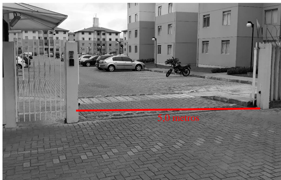
Figura 11 – Portão de Acesso ao Interior da Edificação Fonte: O Autor (2018)
