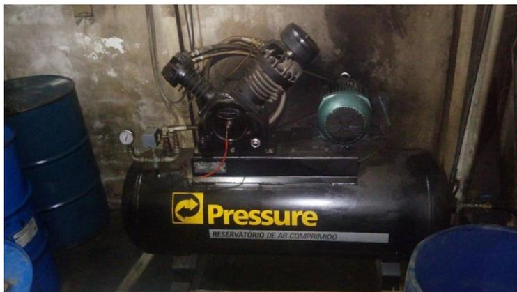
Figura 12 - 1º Vaso de pressão da empresa “A” (compressor de ar)
