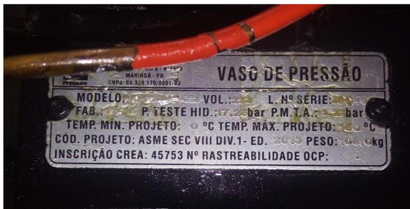
Figura 13 - Plaqueta de identificação do 1º vaso de pressão empresa “A”
