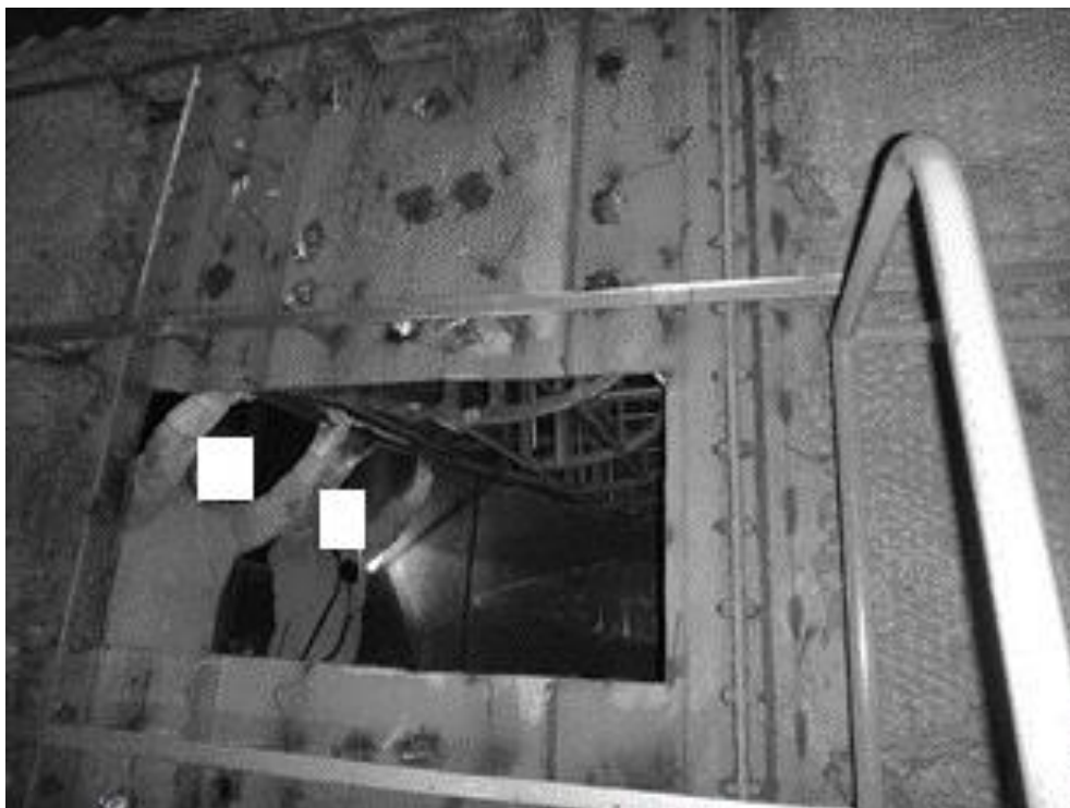
Figura 21 – Substituição de Medidor de Vazão Fonte: Souza (2018).
