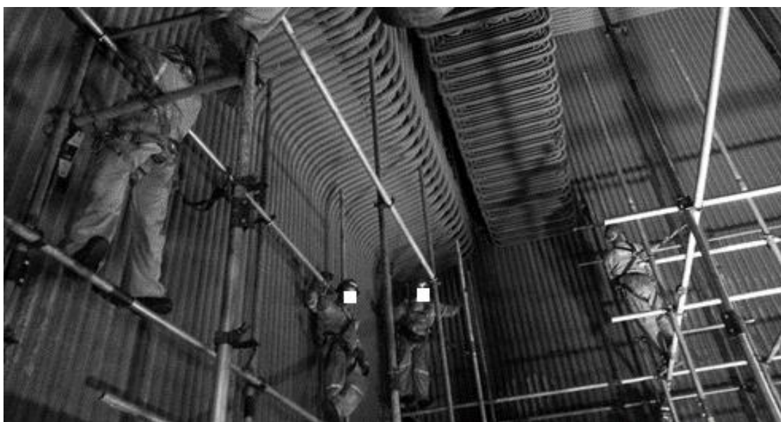
Figura 17 – Montagem de Andaime Fornalha Fonte: Souza (2018).
