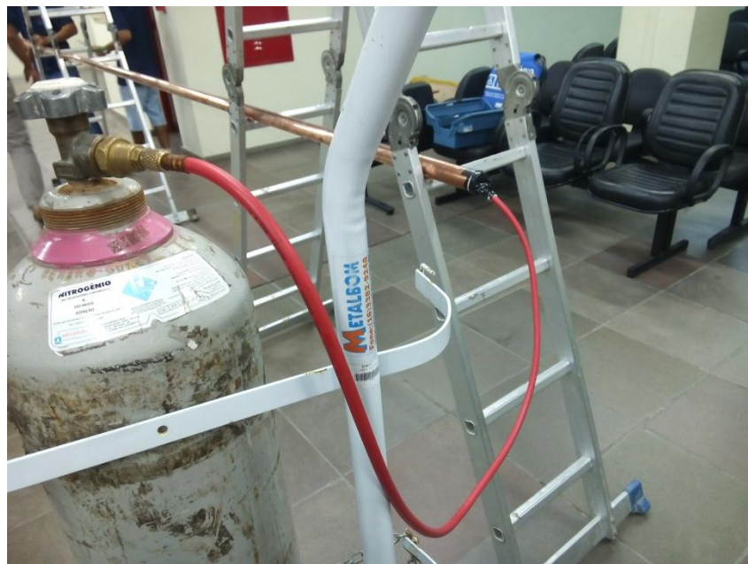
Figura 9 - Cilindro de nitrogênio utilizado pelo soldador "A"
