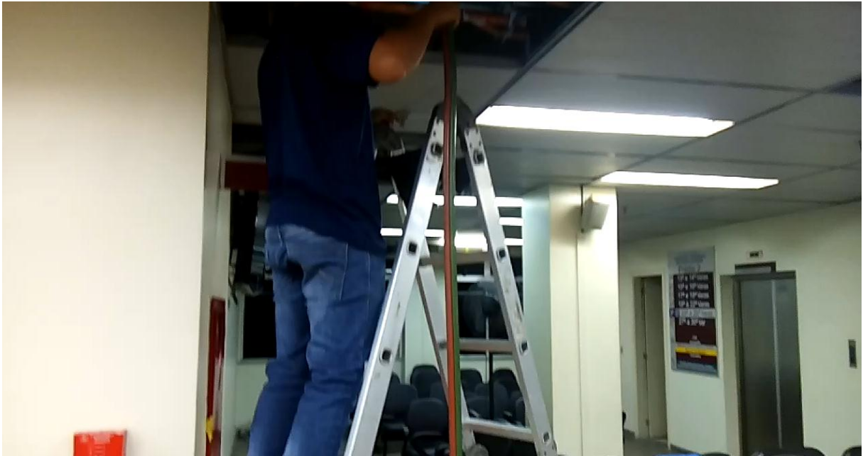
Figura 12 - Soldador "A" realizando os trabalhos sobre a escada
