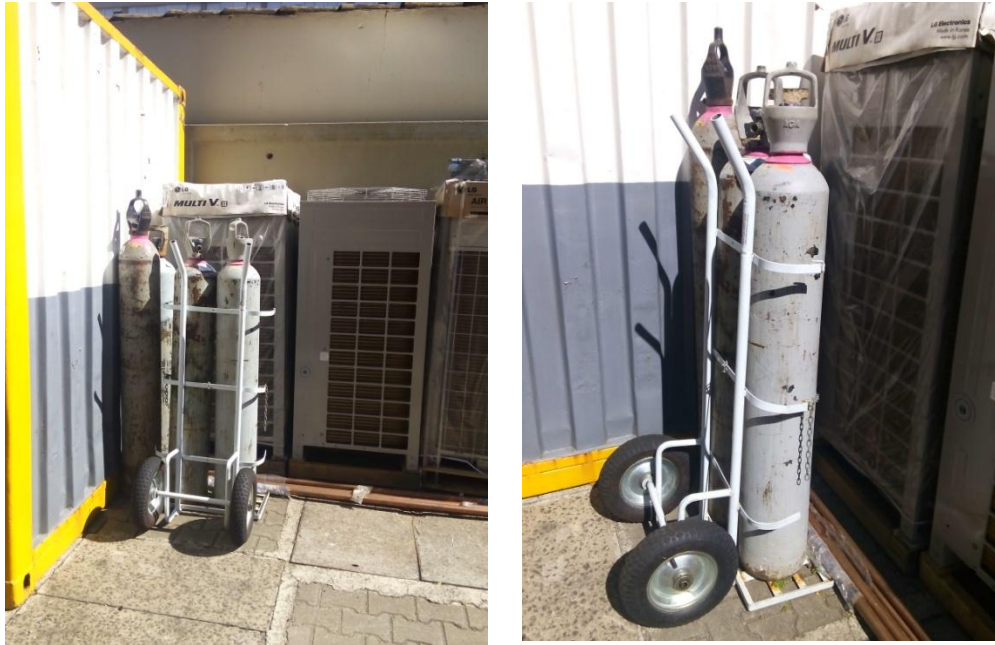
Figura 6 - Armazenagem dos cilindros de nitrogênio
