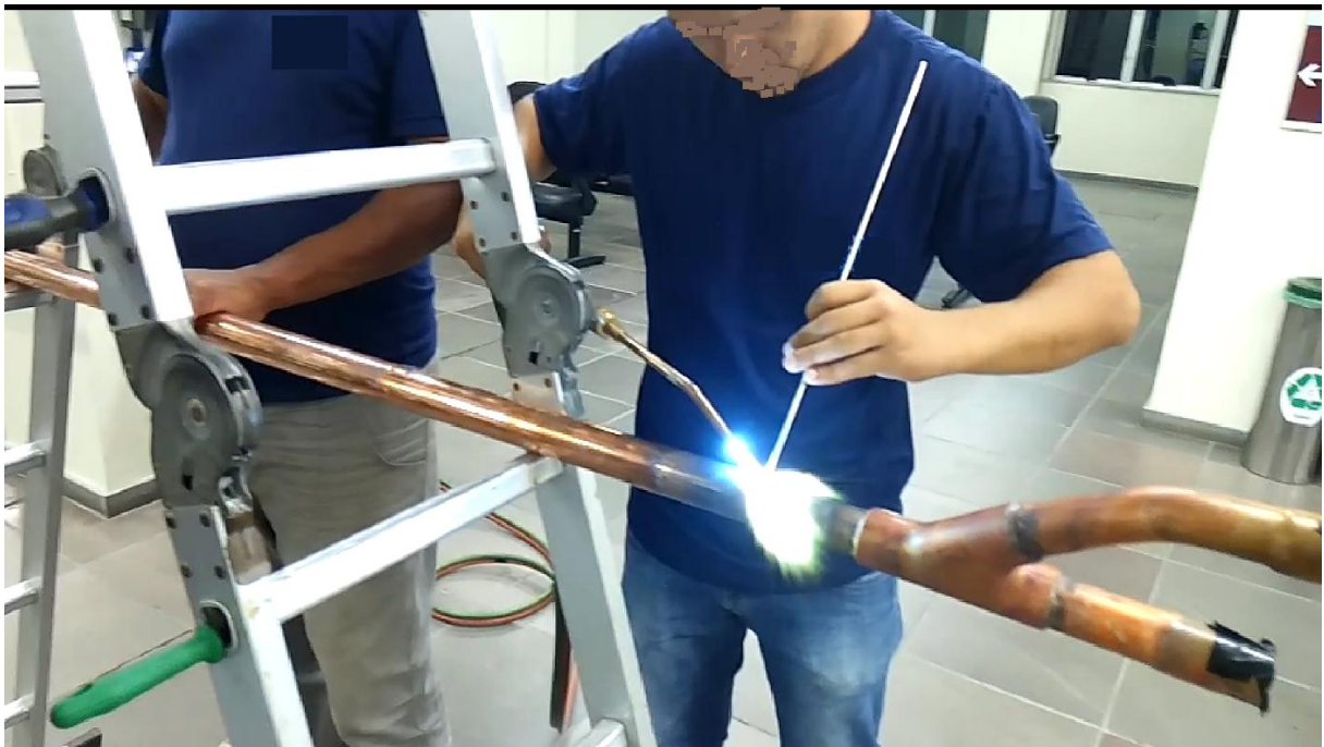
Figura 10 - Soldador "A" exposto a radiação, fumos de solda e gases
