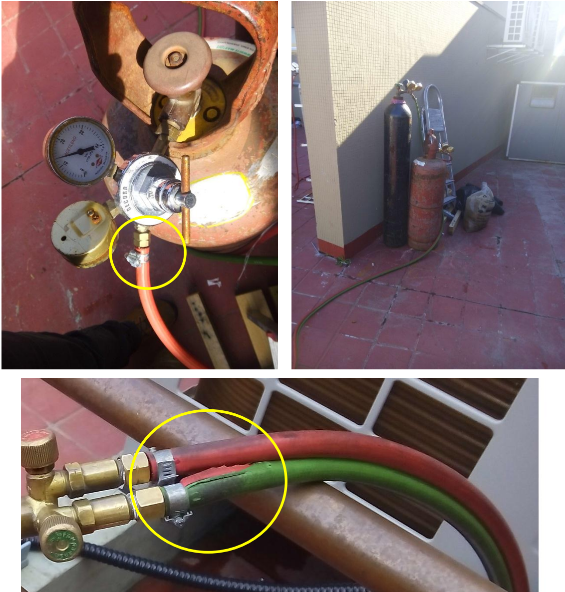
Figura 15 - Equipamento de solda utilizado pelo soldador “B”
