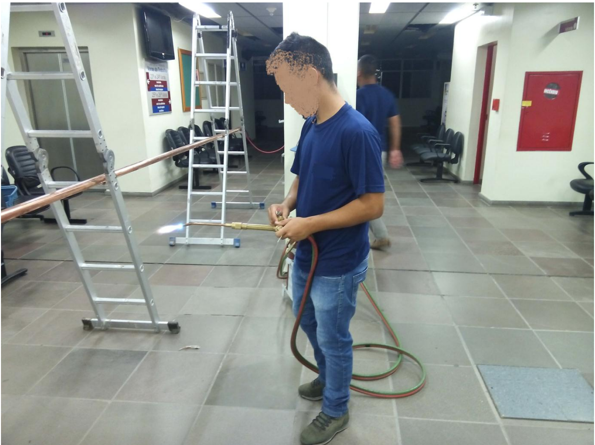
Figura 7 - Estrutura improvisada para a solda na posição plana
