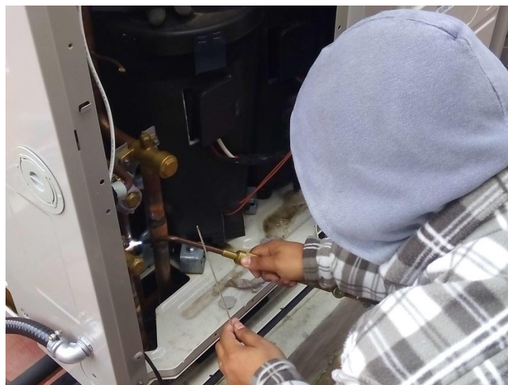
Figura 18 - Soldador “B” exposto a radiação, fumos de solda e gases
