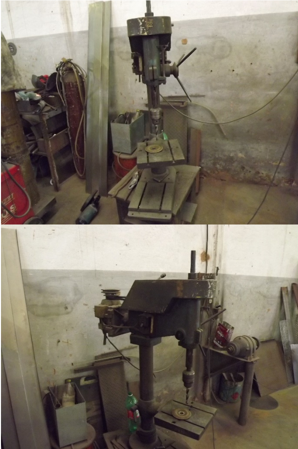
Figura 5 - Máquina para “furar” sem proteção
