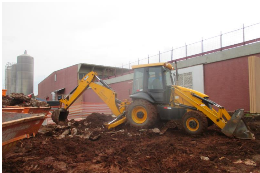
Figura 8 – Retroescavadeira realizando a limpeza do terreno. Fonte: O Autor, 2017.
