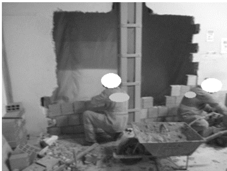
Figura 7 – Pedreiro executando a reconstituição de uma parede de alvenaria. Fonte: O Autor, 2017.
