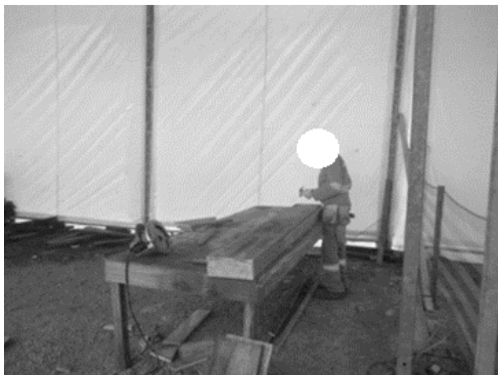
Figura 6 – Carpinteiro realizando a montagem de fôrma para estrutura de concreto. Fonte: O Autor, 2017.
