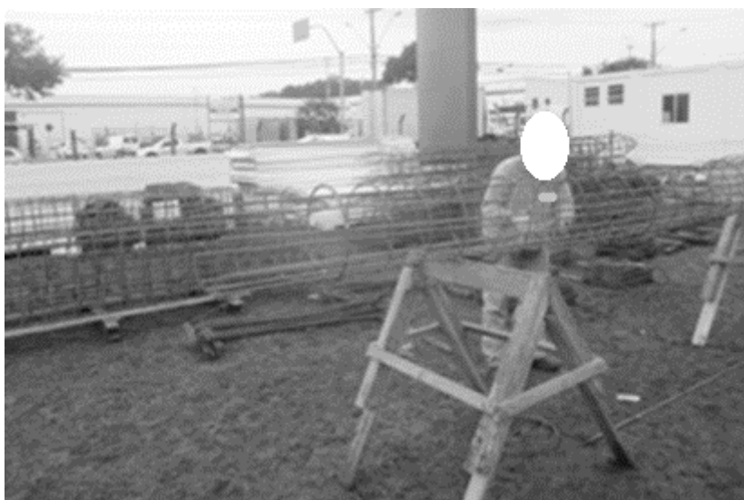
Figura 5 – Armador realizando a montagem de armadura de estaca. Fonte: O Autor, 2017.
