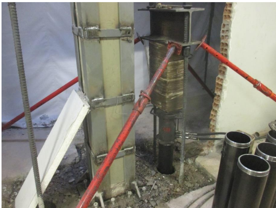
Figura 12 – Cravação da estaca mega. Fonte: O autor, 2017.
