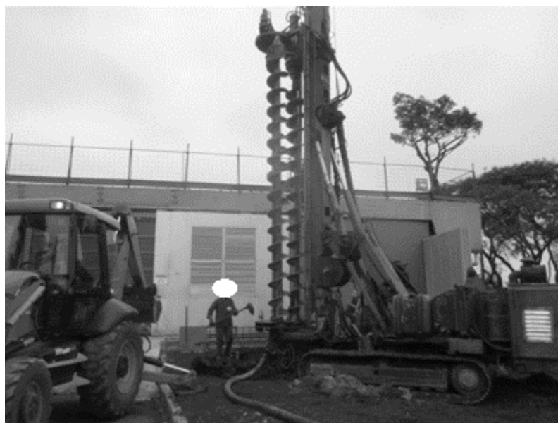
Figura 10 – Execução de estaca hélice contínua monitora segmentada. Fonte: O autor, 2017.
