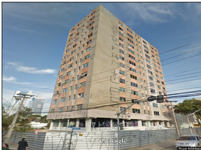
Figura 15: Prédio antes da obra Fonte: Google Earth, 2014.
