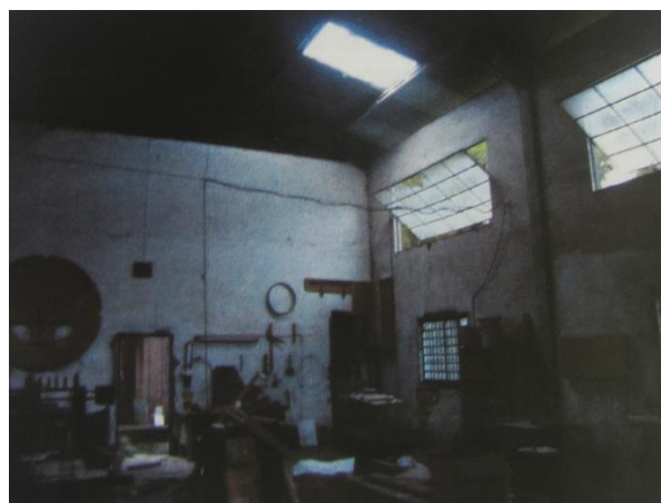
Figura 113- Reforma para troca de telhas
