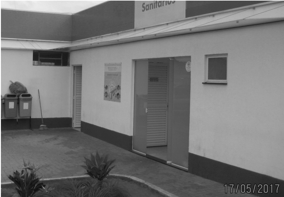
Figura 7 – Sanitários. Fonte: Autor (2017).
