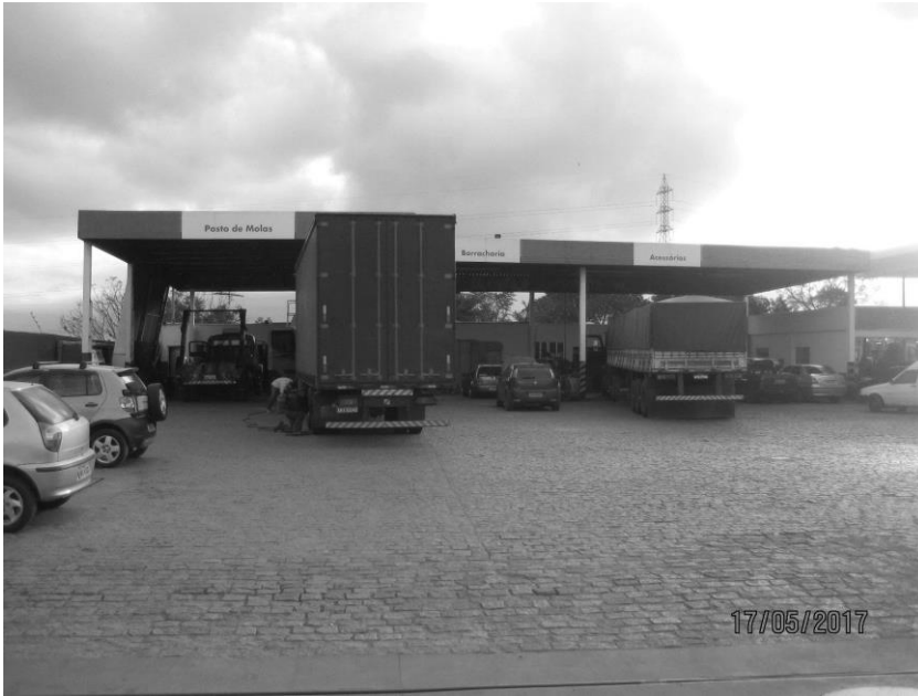
Figura 5 – Área da borracharia, manutenção e acessórios. Fonte: Autor (2017).
