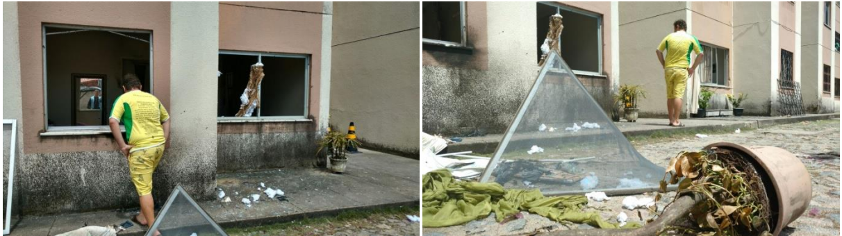
Figura 5 – Acidente por vazamento de gás.
