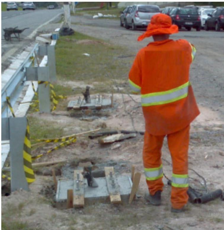
Figura 28 - Trabalhador inserindo os cabos nos conduítes.
