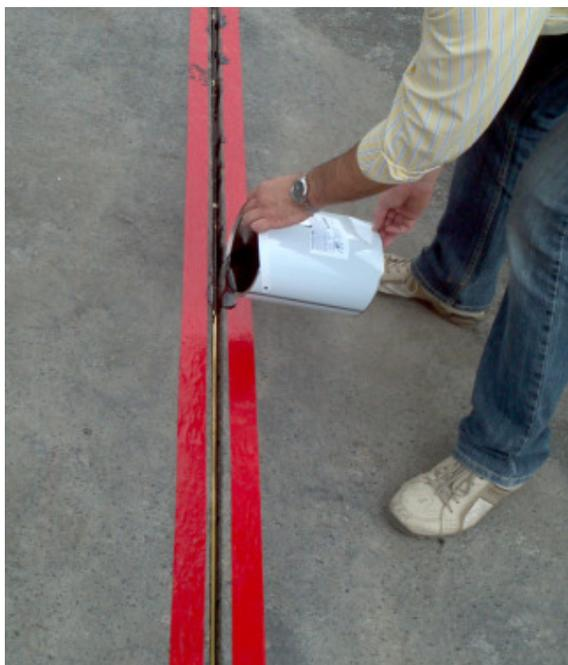
Figura 24 - Cobrindo os cortes com piche para proteger os laços
