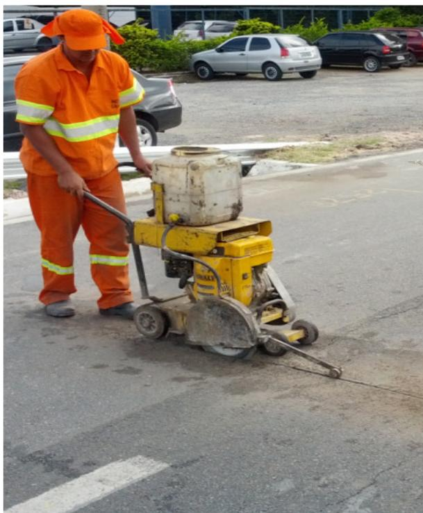
Figura 21 - Trabalhador utilizando serra circular para cortando o pavimento.
