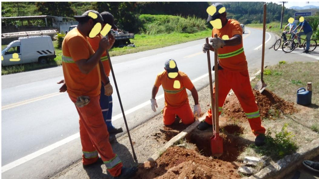
Figura 25 - Escavações para instalação de base e caixa de passagem.
