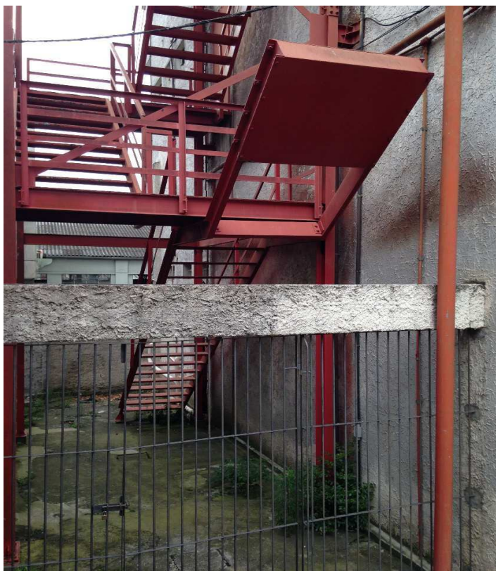
Figura 9: Piso de descarga e último lance móvel da Escada de Incêndio Fonte: Autor (2015)
