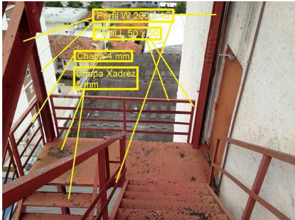
Figura 6: Materiais que compõe a estrutura da Escada de Incêndio Fonte: Autor (2015)
