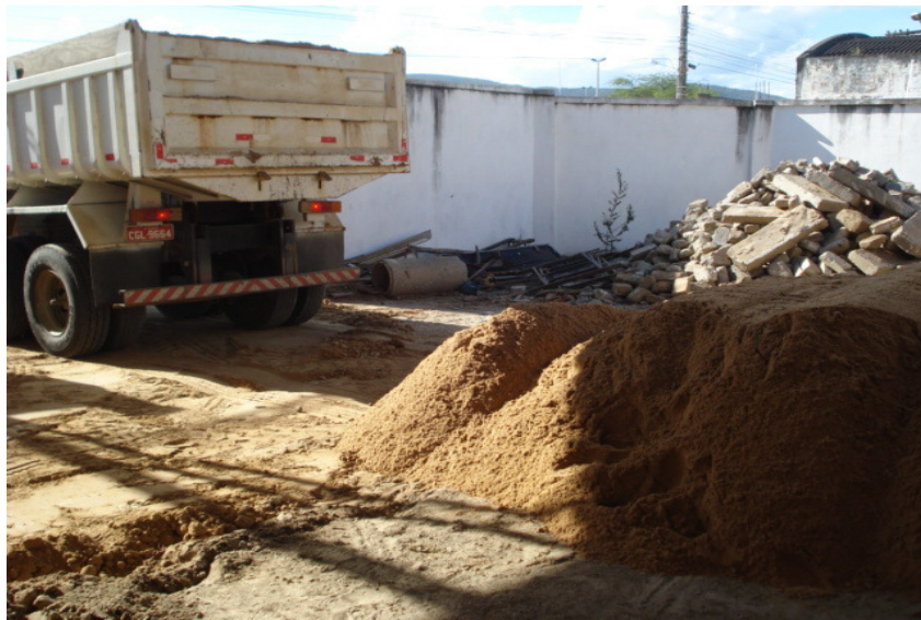
Figura 08 – Reaterro de solo na cava
