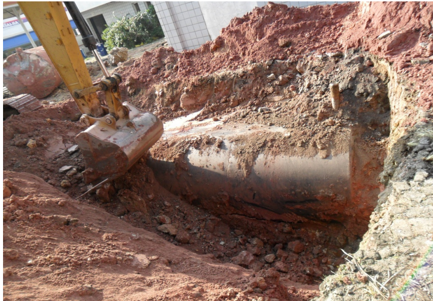
Figura 06 – Escavação do tanque subterrâneo
