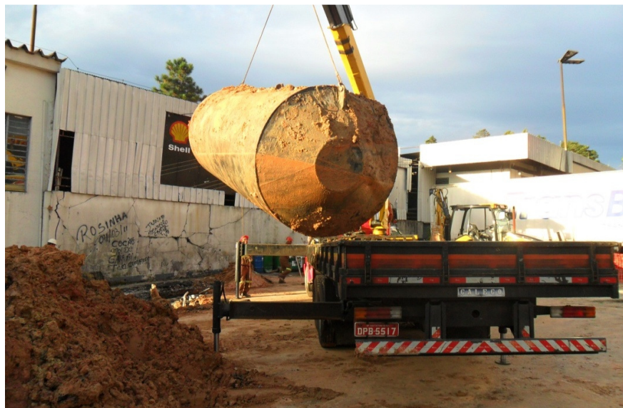
Figura 07 – Içamento do tanque subterrâneo
