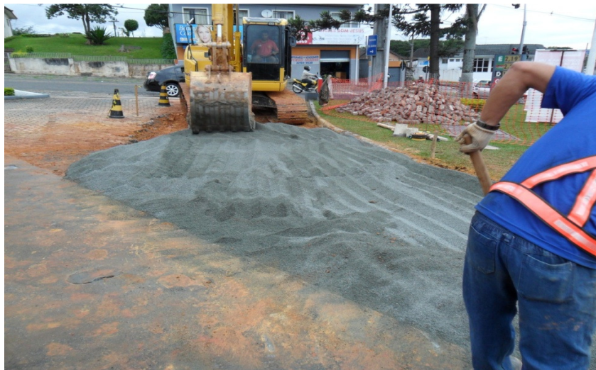
Figura 10 – Recomposição de piso
