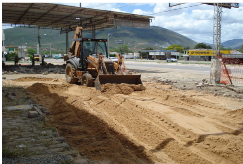
Figura 09 – Compactação de solo na cava
