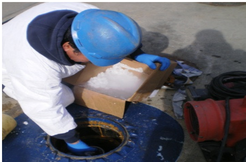
Figura 03 – Inserção de gelo seco em tanque subterrâneo
