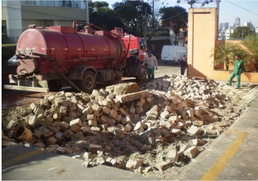
Figura 02 – Hidrojateamento do tanque subterrâneo
