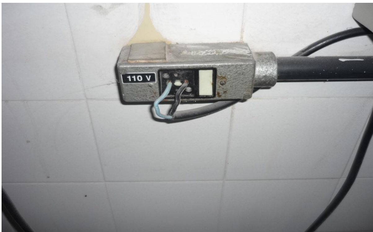
Figura 12 - Tomada baixa tensão. Fonte: Próprio autor
