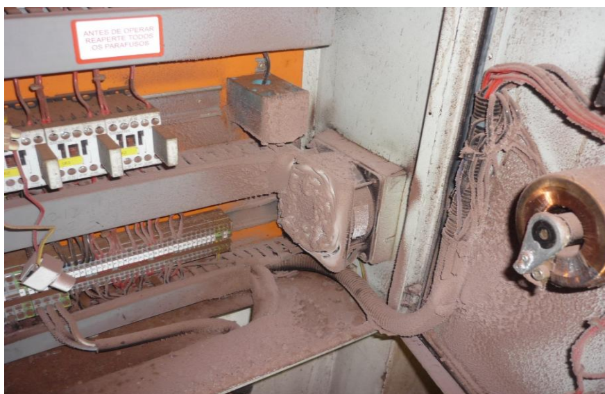
Figura 9 - Quadro de comando máquina de embalar. Fonte: Próprio autor
