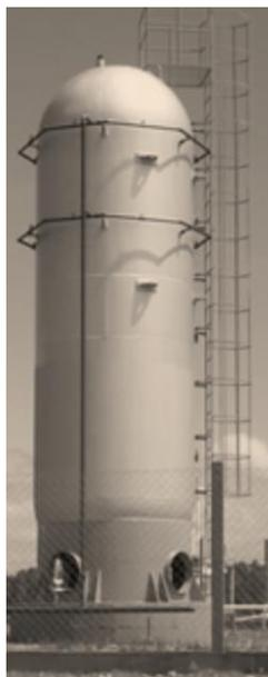
**Figura 3 – Vaso de pressão vertical de com capacidade de 20 toneladas GLP**
