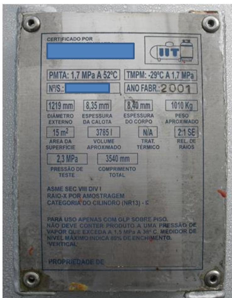
**Figura 8 - Modelo de placa de vaso pressão para GLP**
