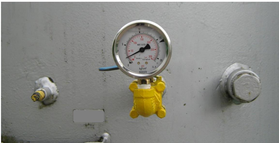
**Figura 13 - Dispositivo indicador de pressão (manômetro).**
