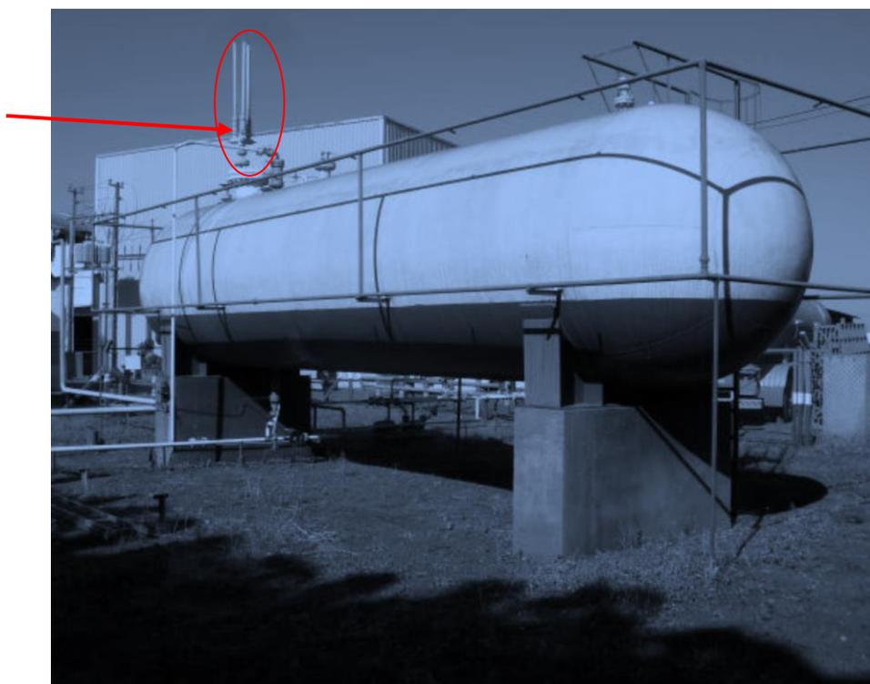
**Figura 12 - Posição das válvulas de alívio em um vaso de pressão para GLP.
