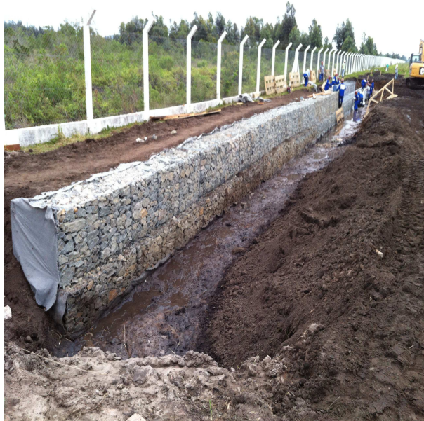
Figura 4 – Muro de contenção à gravidade em gabhões
