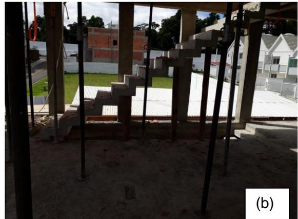
**Figura 14- Situações encontradas no local: (a) periferia de laje sem proteção contra queda; (b) escada de uso coletivo sem proteção contra queda.**
