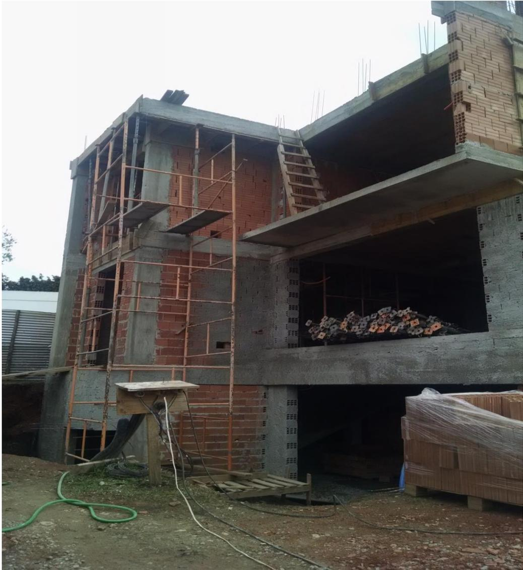
Figura 15- Escada de mão colocada na extremidade de uma laje.
