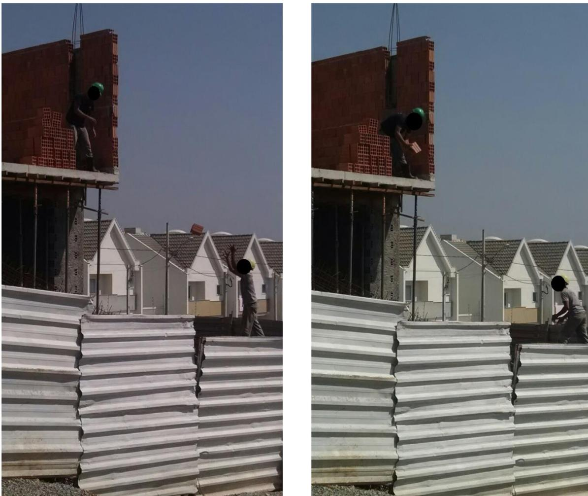
**Figura 24- Sequência de lançamento manual de materiais.**
