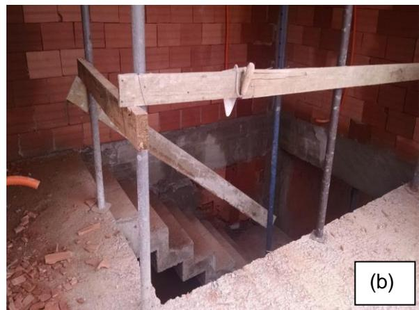
Figura 16- Proteções coletivas em desacordo com a NR- 35: (a) proteção horizontal em abertura no piso; (b) guarda-corpo em escada de uso coletivo.
