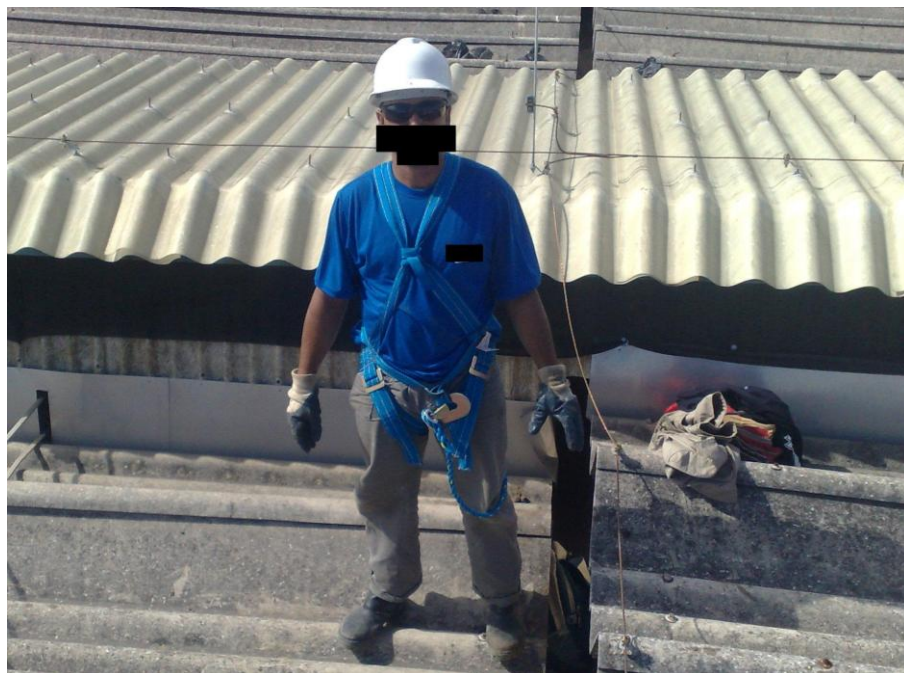
Figura 25: Funcionário equipado com EPIs para o trabalho de instalação de calhas em telhado de galpão industrial. (FIRETTI, 2012)
