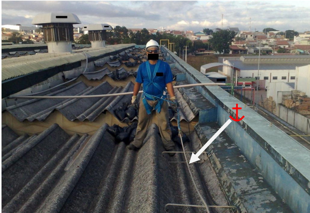
Figura 26: Linha de vida horizontal temporária (identificada pela seta). (FIRETTI, 2012)
