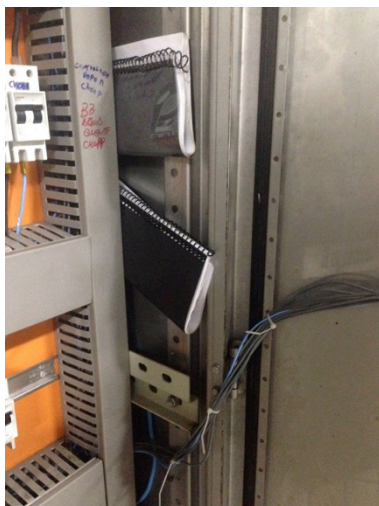
Figura 4 - Diagrama funcional em local inadequado Fonte: o autor, 2015
