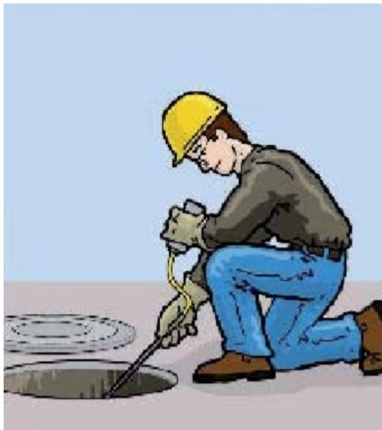
**Figura 5: Medição de gases**
