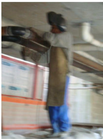
Figura 11 - Utilização de EPI
