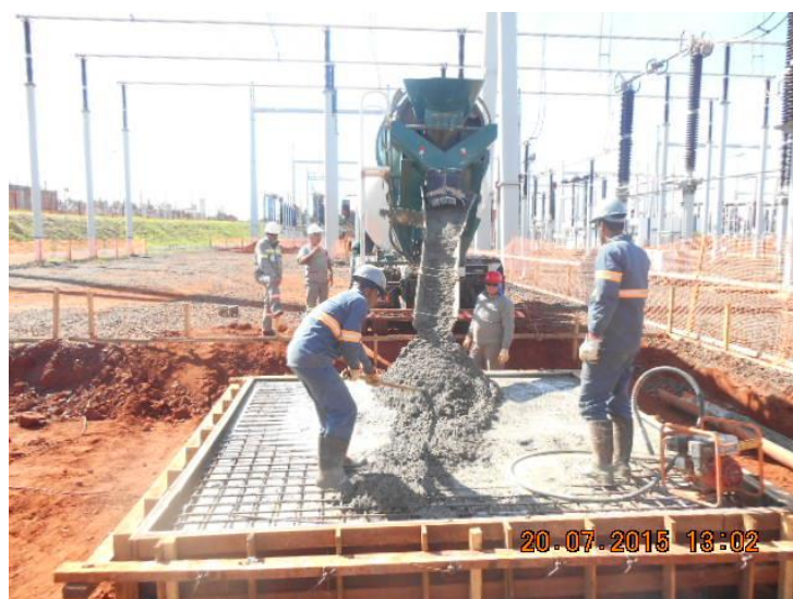
Figura 6 - Concretando uma fundação Fonte: Autoria própria
