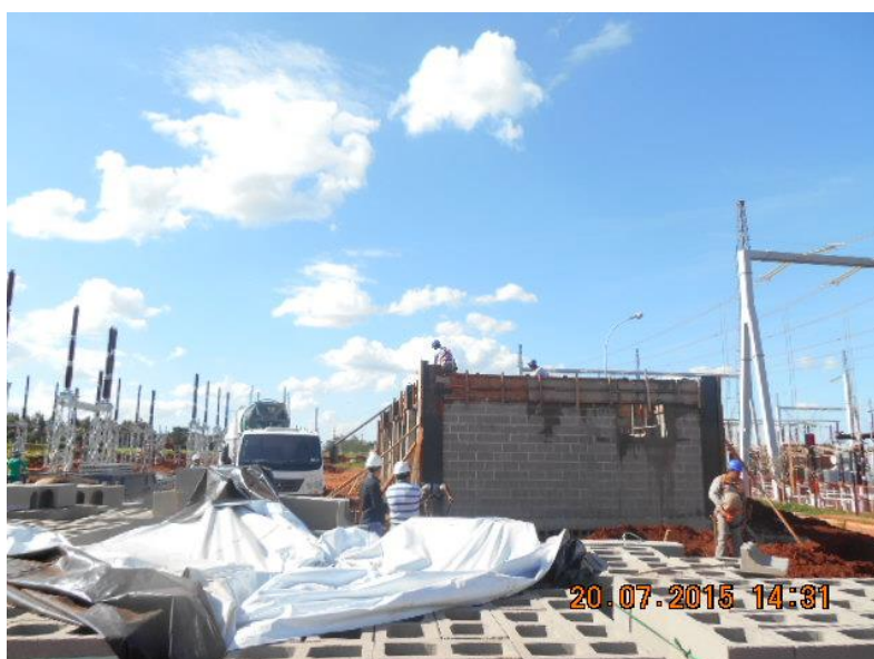
Figura 9 - Execução da casa de comando
