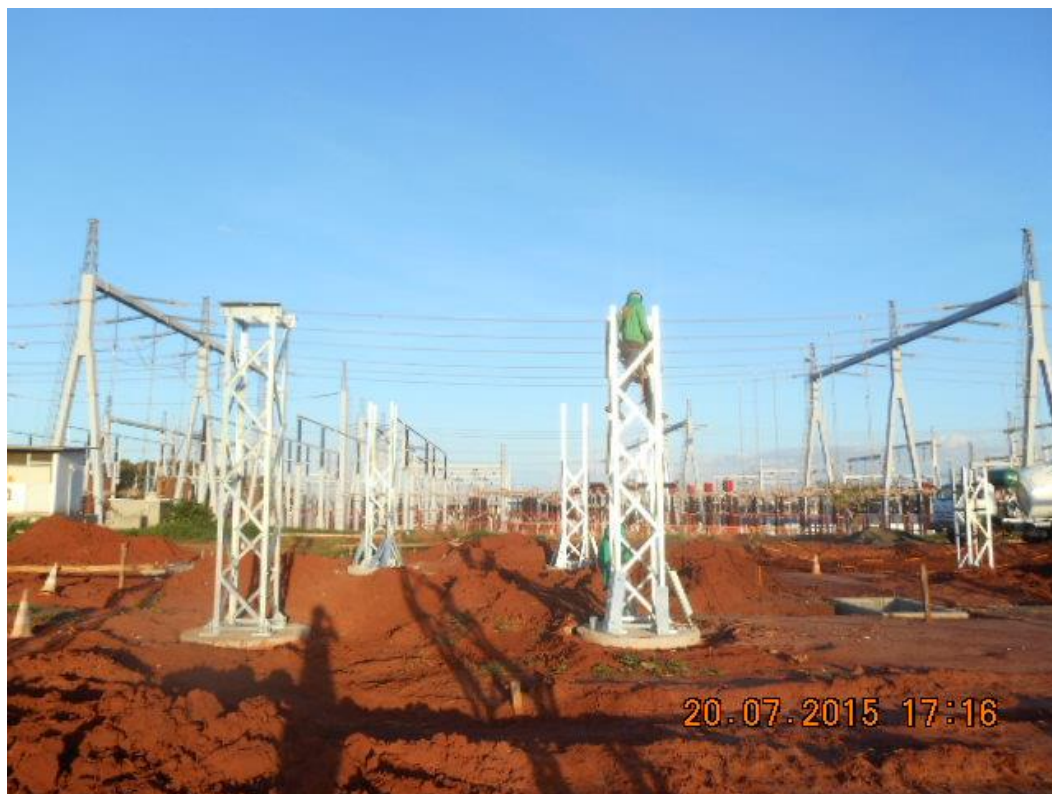
Figura 13 - Montagem de suporte de equipamentos Fonte: Autoria própria
