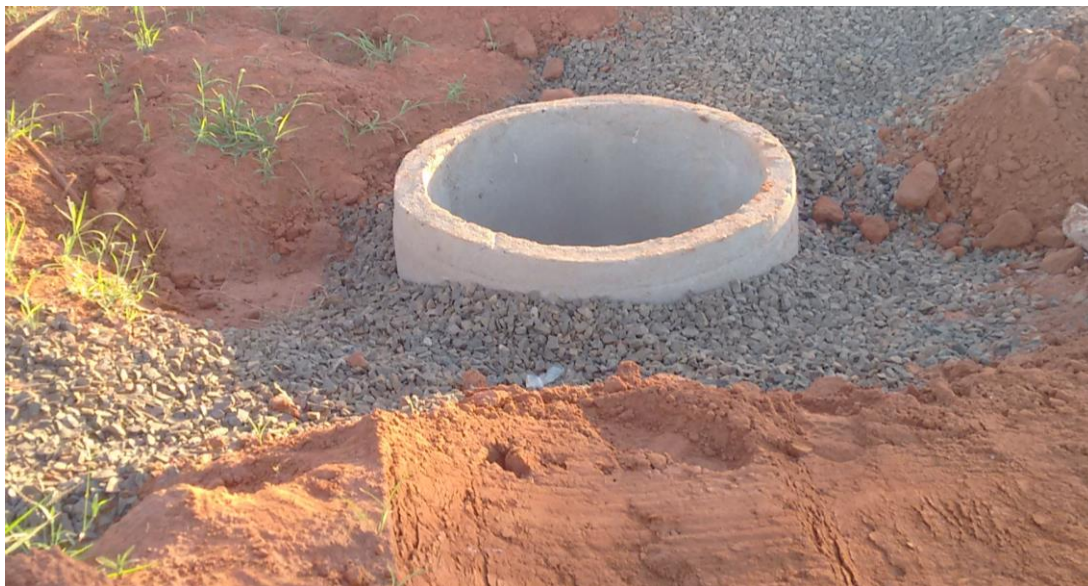
Figura 5 – Drenagem Fonte: Autoria própria
