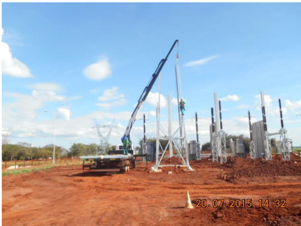
Figura 11 - Montagem de pórtico Fonte: Autoria própria
