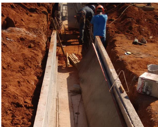
Figura 8 - Execução de canaletas Fonte: Autoria própria
