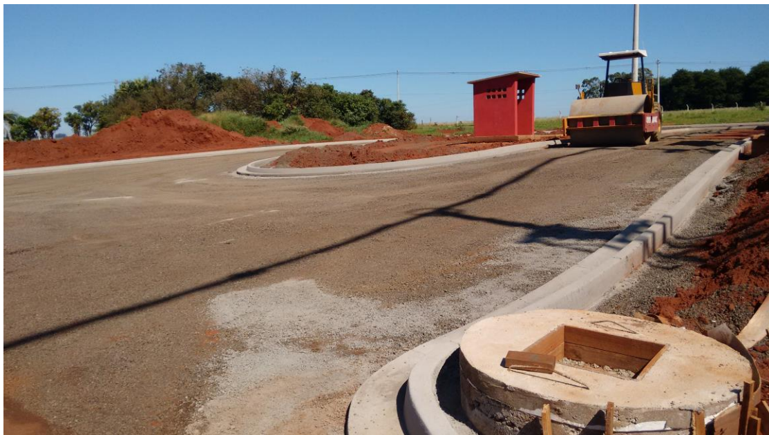
Figura 10 - Vias de acesso Fonte: Autoria própria
