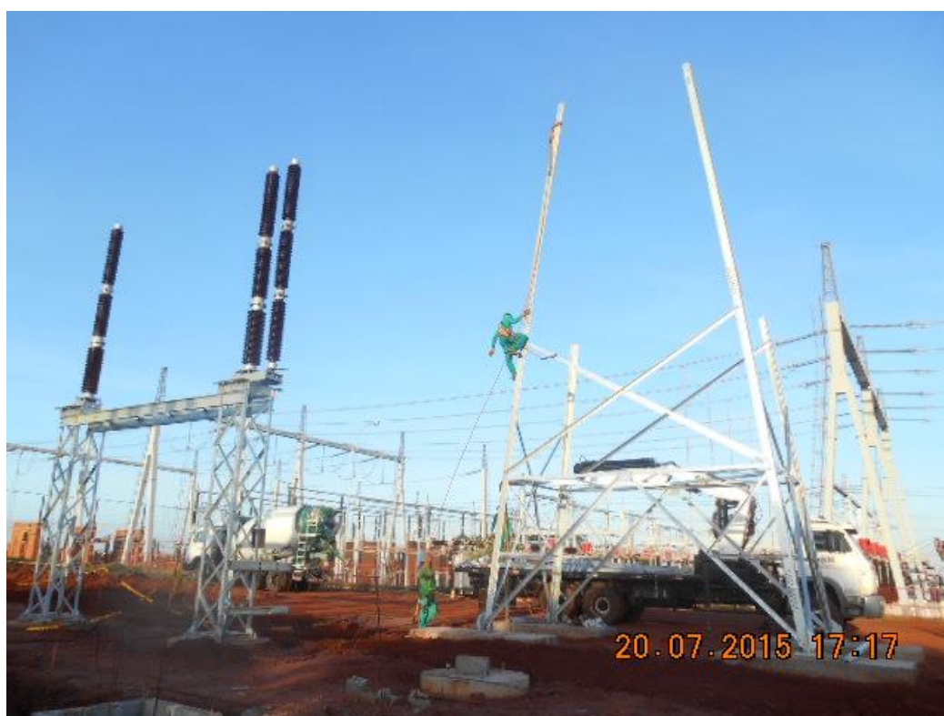
Figura 12 - Montagem de pórtico Fonte: Autoria própria
