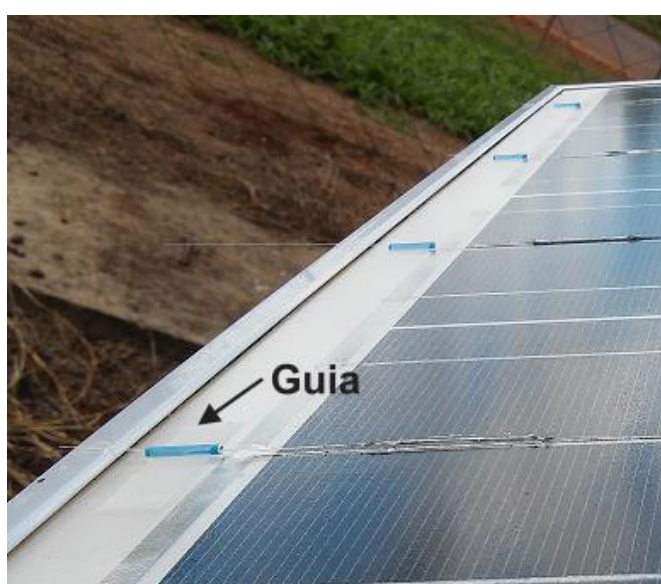
Figura 19 - Instalação das guias para os cordões de fibra Fonte: Autoria própria
