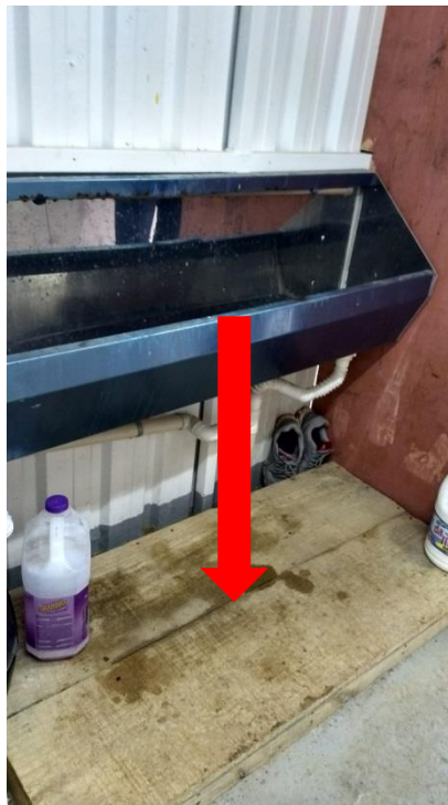
Figura 21: Obra B. Mictório com altura superior a 0,50m do piso Fonte: A autora (2017).
