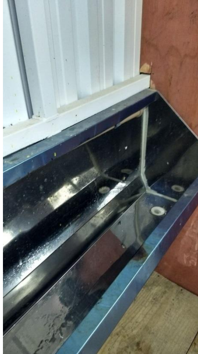
Figura 22: Obra B. Mictório com revestimento interno de material liso, impermeável e lavável. Fonte: A autora (2017).
