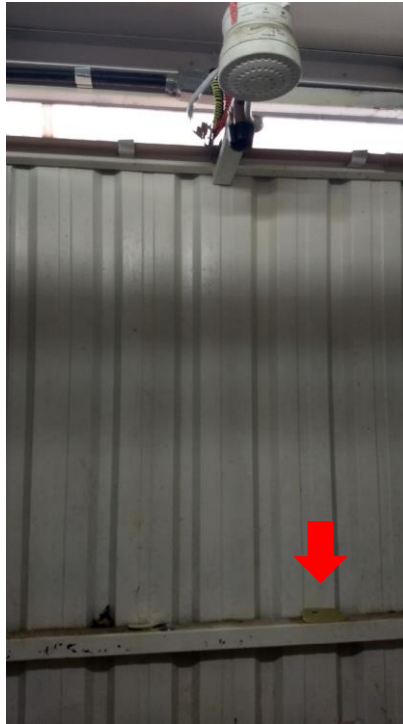
Figura 25: Obra B. Chuveiro e suporte para sabonete Fonte: A autora (2017).
