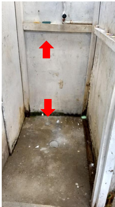
Figura 28: Obra C. Piso do chuveiro e suporte para sabonete Fonte: A autora (2017).
