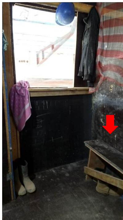
Figura 29: Obra A. Banco em número insuficiente
