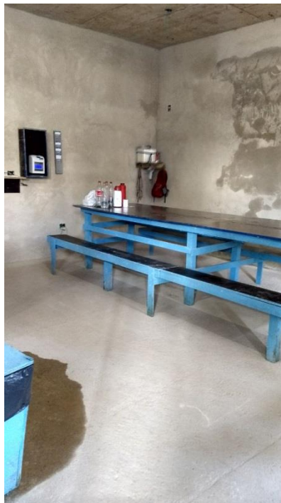
Figura 34: Obra A. Refeitório 01 provido de mesa com tampo liso e lavável Fonte: A autora (2017).
