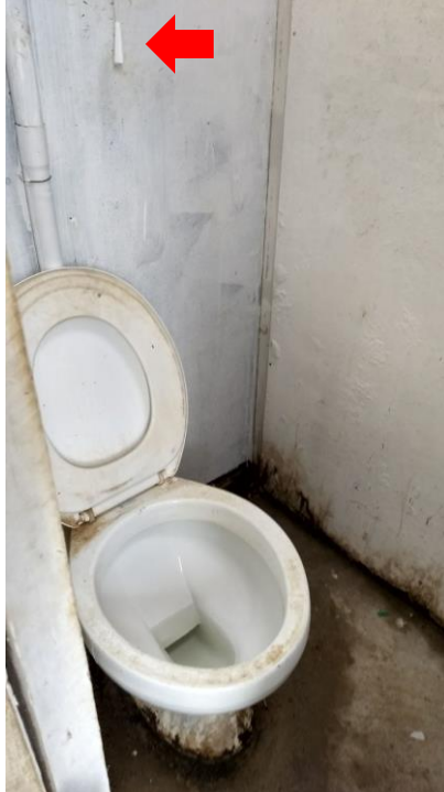
Figura 19: Obra C. Vaso sanitário com caixa de descarga provida de puxador Fonte: A autora (2017).
