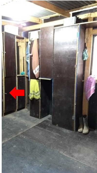
Figura 30: Obra A. Armários individuais dotados de fechaduras Fonte: A autora (2017).
