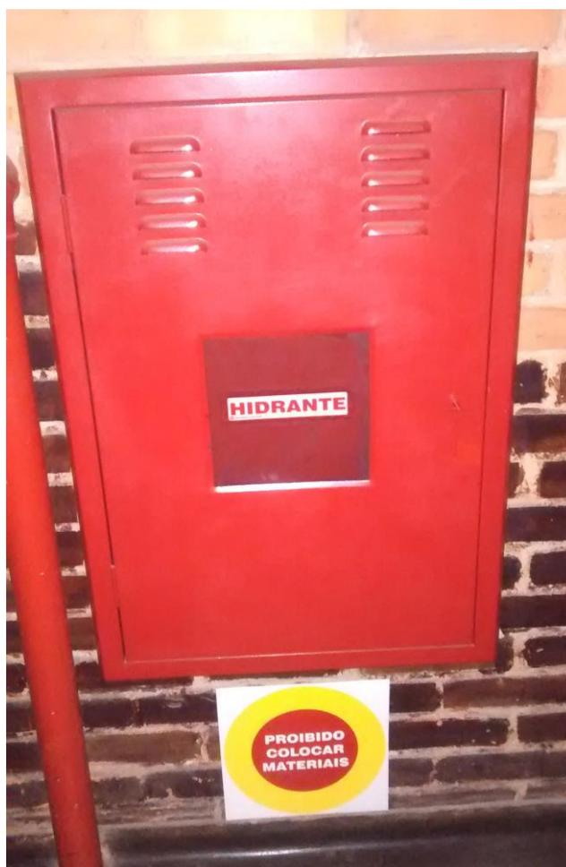
**Figura 9 - Caixa de hidrante sem mangueira**
