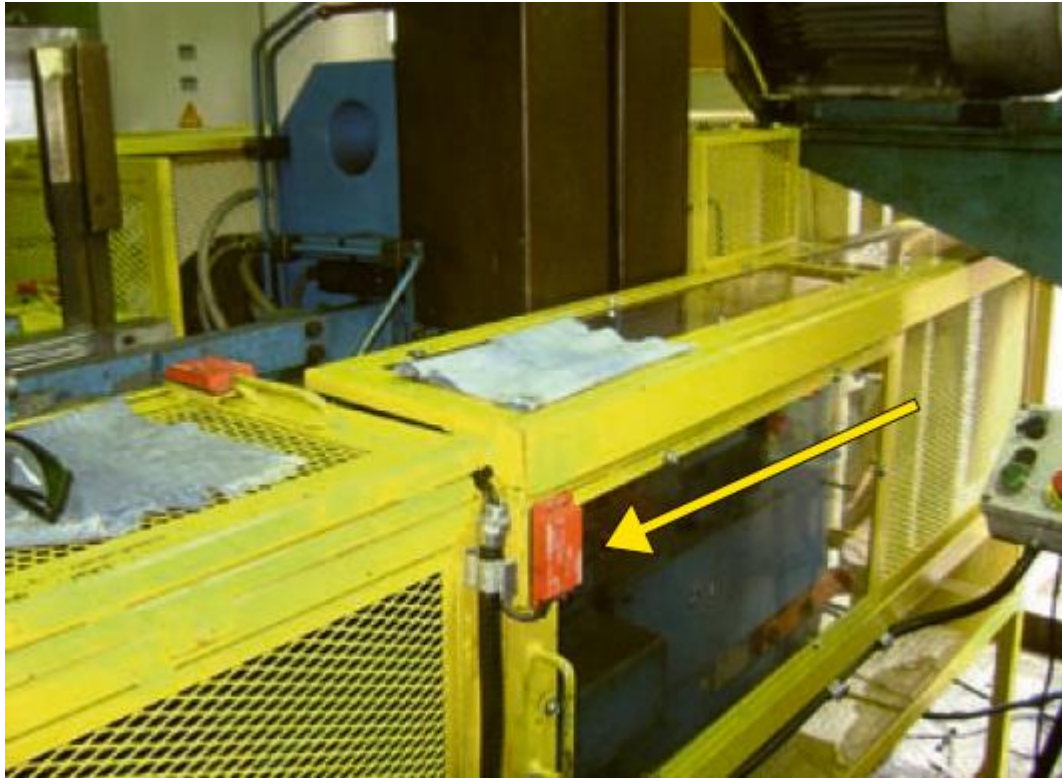
Figura 7 - Proteção móvel com intertravamento na posição fechada Fonte: ABIMAQ 2012.
