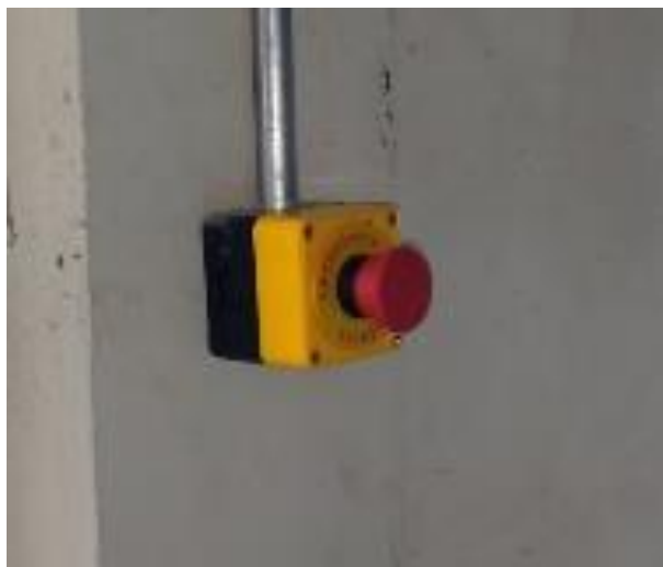
Figura 13 - Botão de Emergência e Reset
