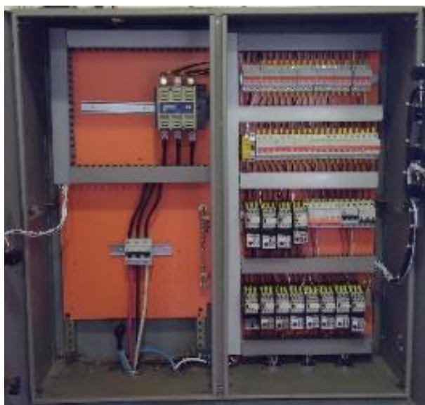
Figura 14 - Contatores - Relês de Segurança
