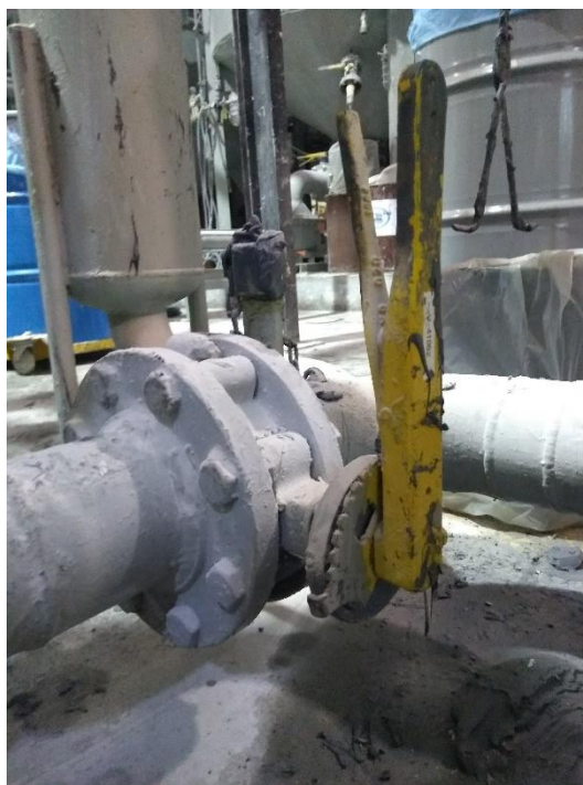
Figura 12 Válvula modelo borboleta Fonte: A Autora, 2018.
