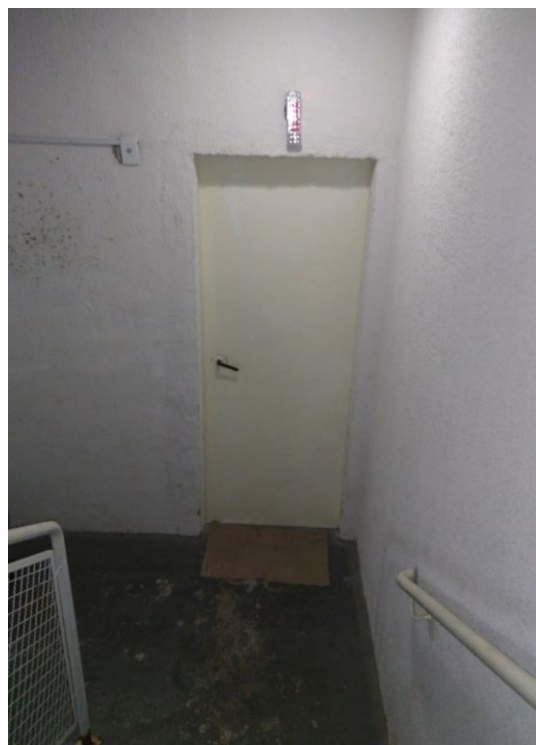
Figura 20 – Porta corta-fogo do térreo visto da escada
