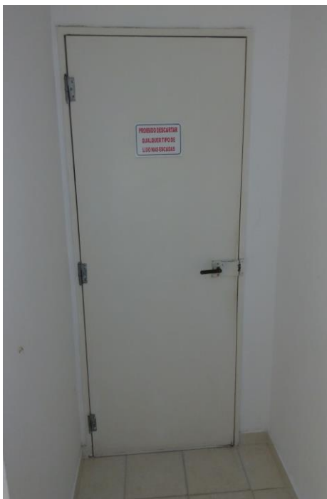
Figura 21 – Porta corta-fogo do térreo visto do Hall
