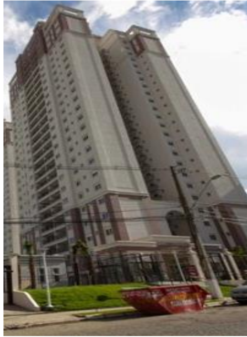
FIGURA 18: Fachada do Condomínio B
