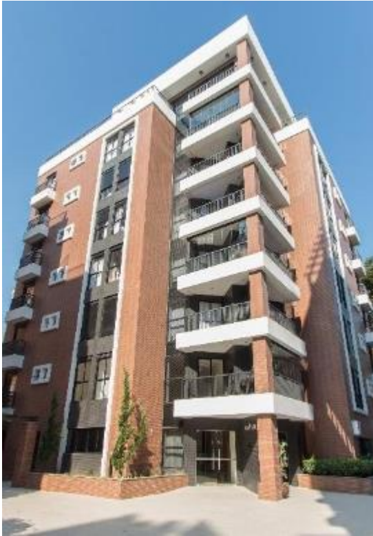
FIGURA 17 - Fachada do Condomínio A
