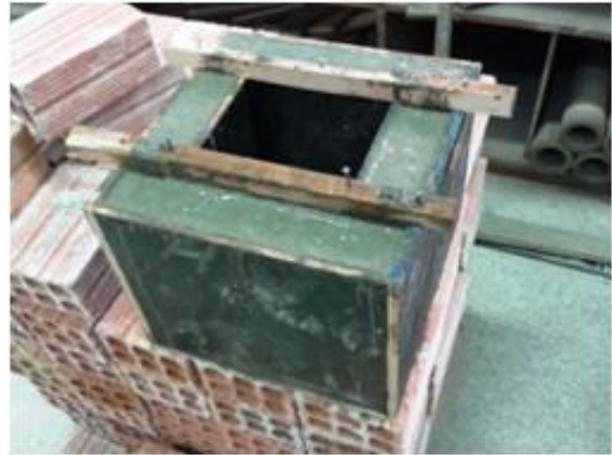
Massa de concreto no molde
