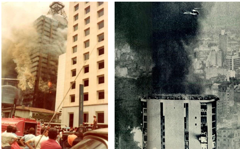
Figura 3 – Incêndio no Edifício Andraus.
