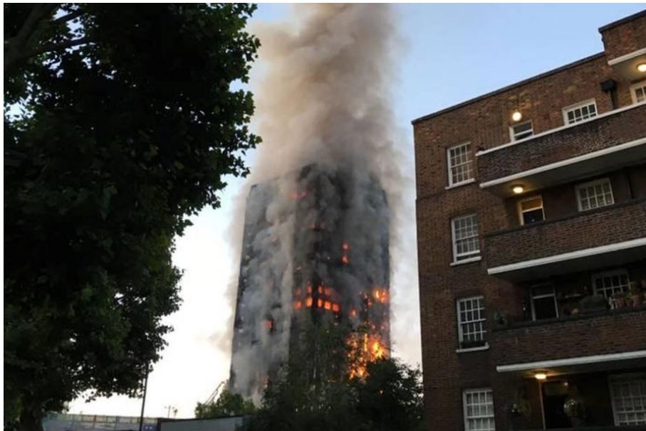
Figura 8 – Torre Grenfell em Chamas.
