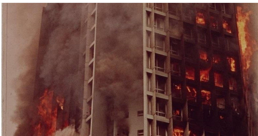
Figura 4 – Edifício Joelma Consumido pelas Chamas.
