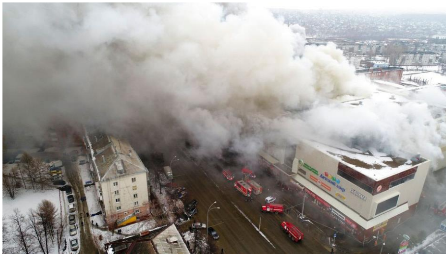
Figura 10 – Revestimento da Fachada Queimando. Fonte: Site G1. 2018.
