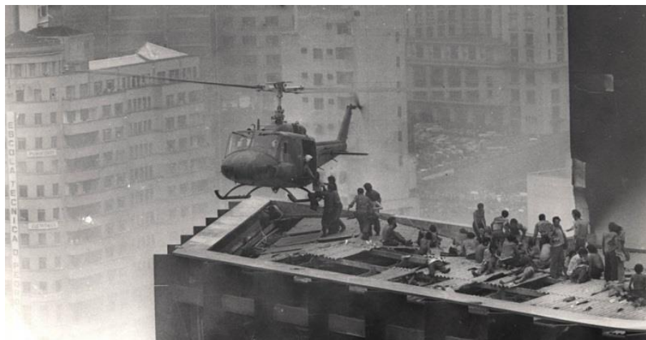
Figura 5 – Ocupantes do Edifício Sobem à Cobertura na Tentativa de Serem Resgatados.
