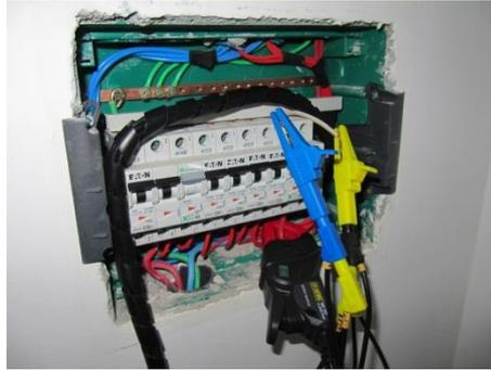
**Fotografia 6 - Ligação dos equipamentos de Medição**
