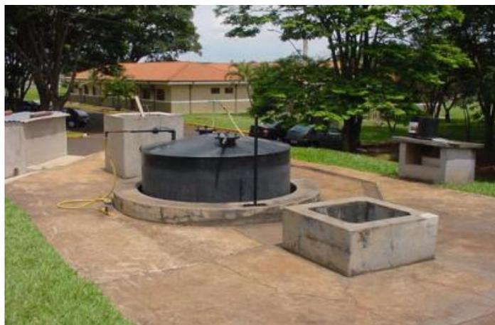
Figura 5 – Biodigestor do modelo indiano
