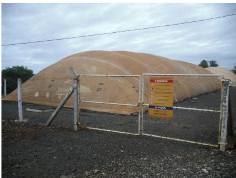
**Figura 7 – Biodigestor do modelo canadense**
