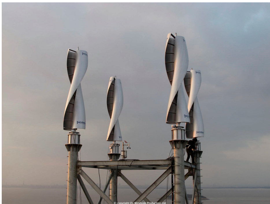
Figura 5 – Aerogerador de eixo vertical tipo Savonius Fonte: Arquexpo, 2015.
