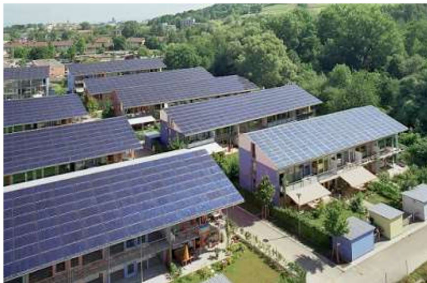
Figura 11 - Sistema fotovoltaico integrado a edificação
