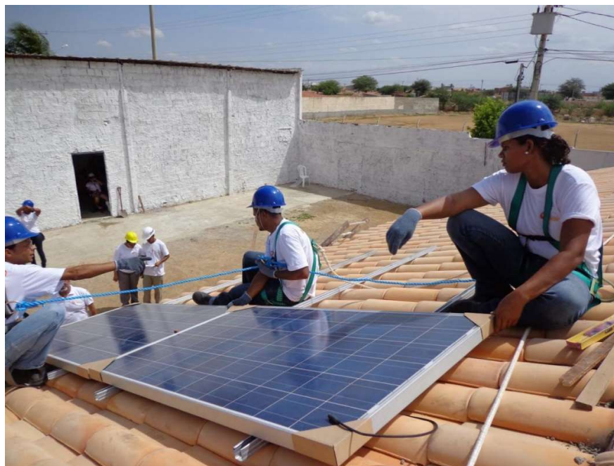
Figura 10 - Trabalhadores durante a instalação de um módulo fotovoltaico.
