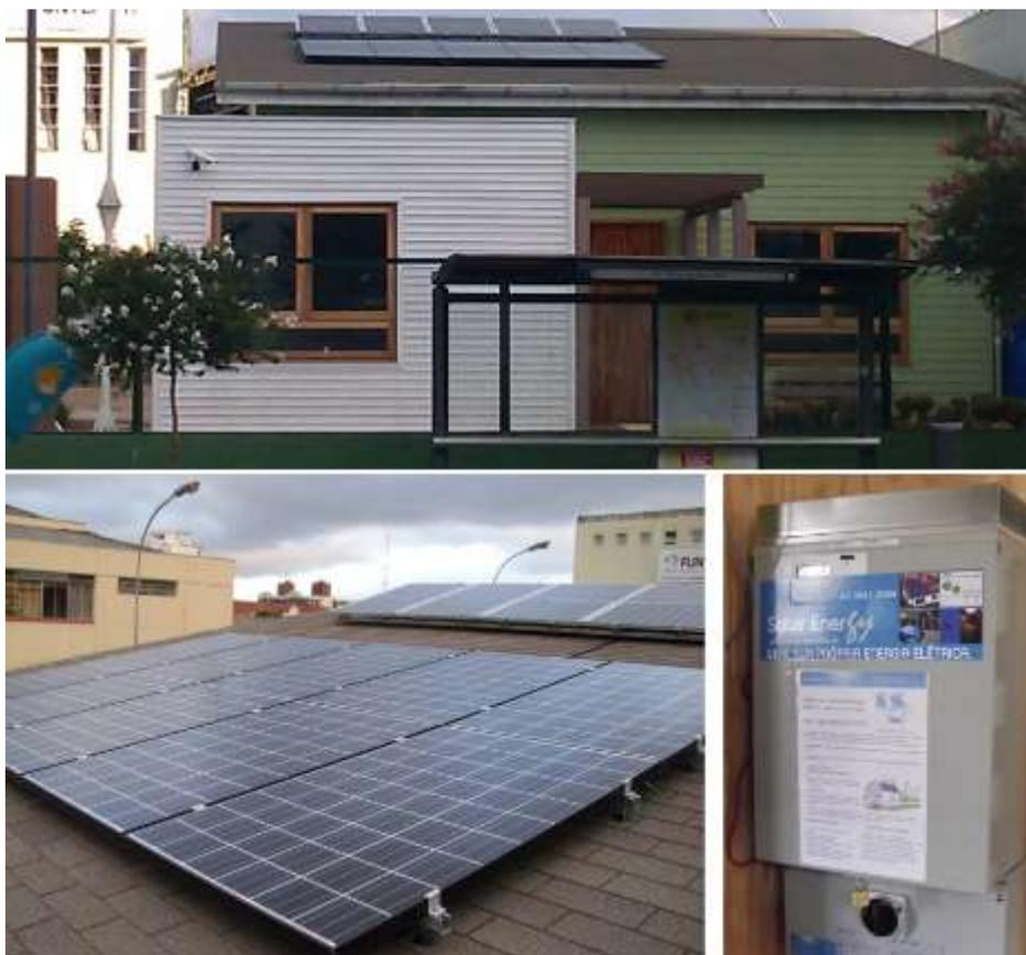
**Figura 21: Vista frontal do EV de UTFPR e detalhe dos painéis e inversor**
