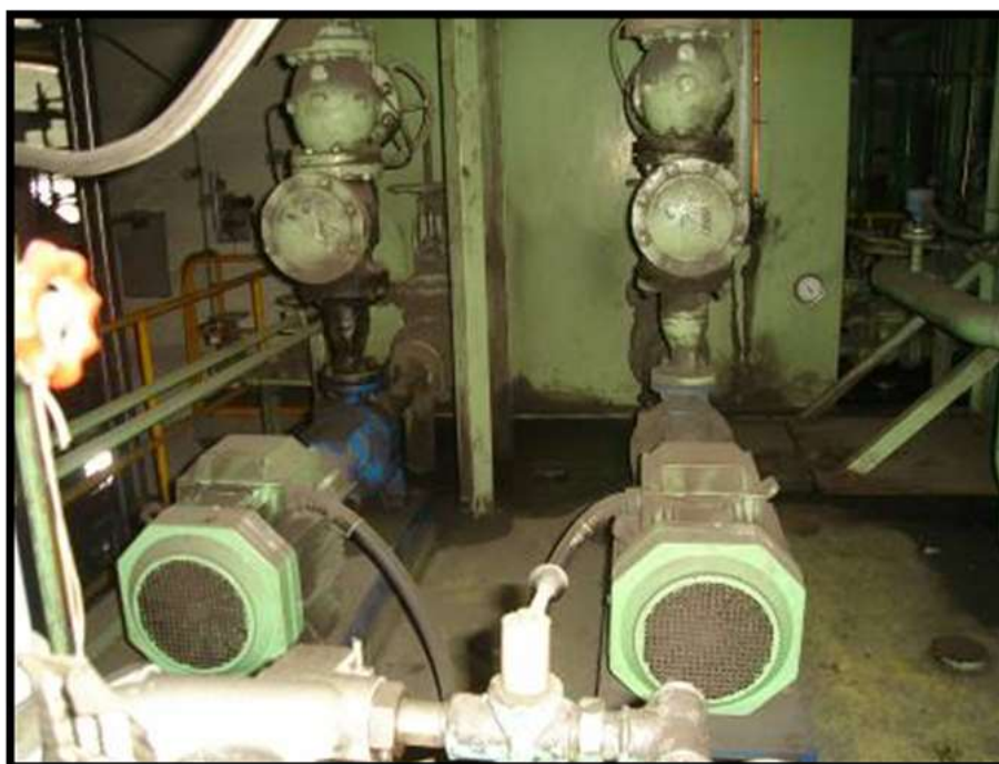
Figura 4 – bomba de óleo de lubrificação
