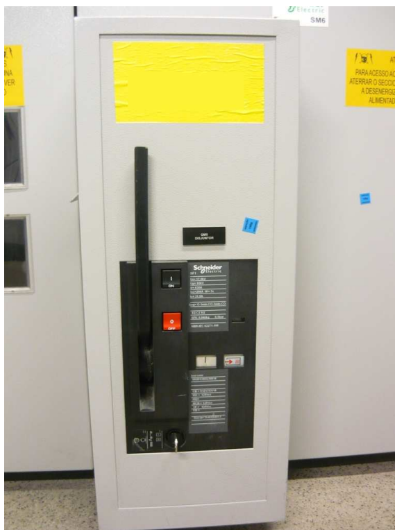
Figura 8 - Foto do Disjuntor Típico de Alta Tensão Fonte: Autoria própria
