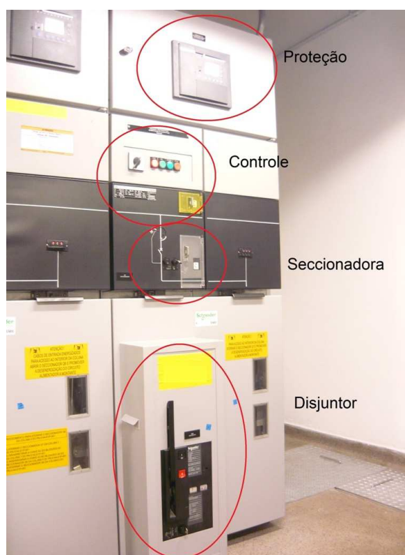
Figura 7 - Foto do Cubículo Típico de Alta Tensão Fonte: Autoria própria
