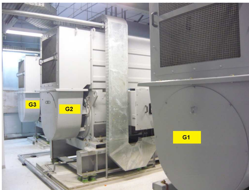
Figura 13 - Foto dos Geradores Fonte: Autoria própria
