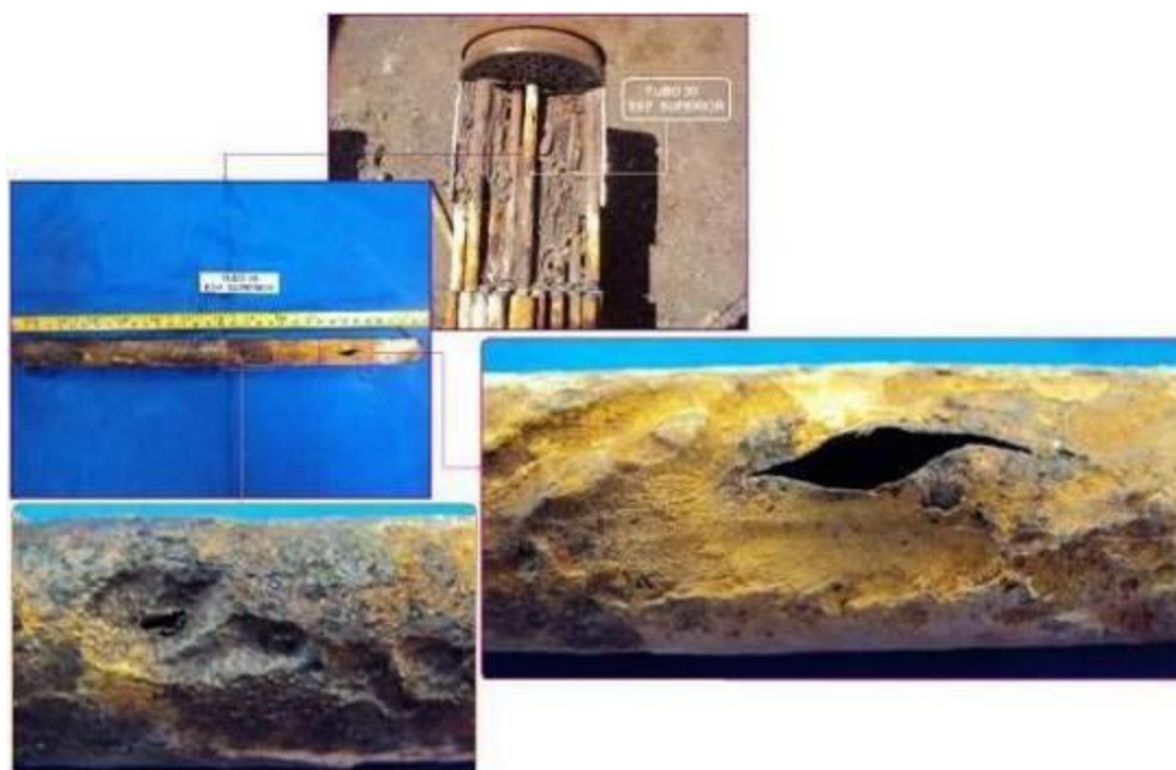
Figura 8 Falha de um tubo do trocador do quarto estágio do compressor de CO 2 devido à corrosão sob depósitos
