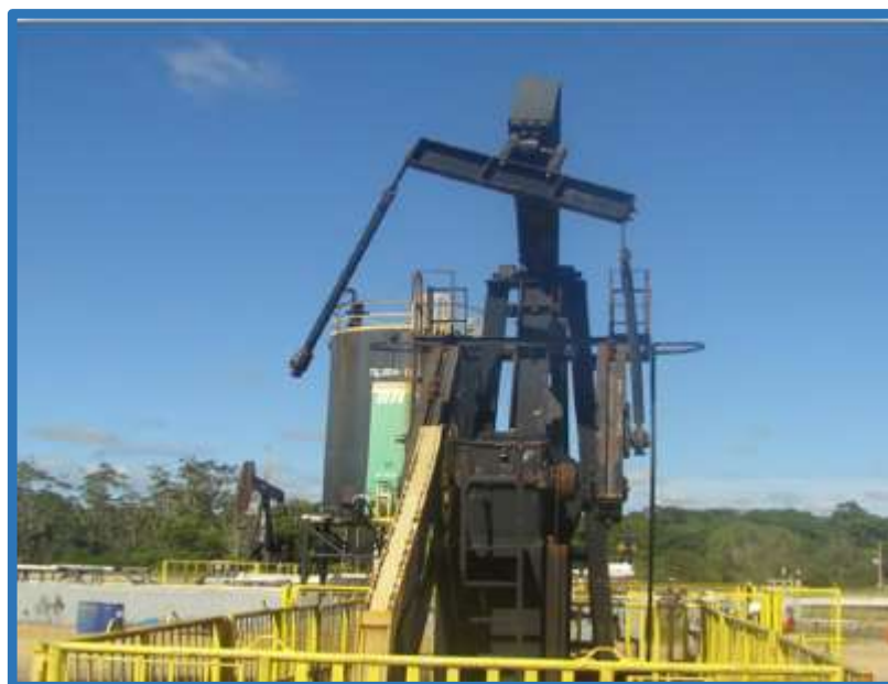
Fotografia 2 - Exemplo de desprendimento do mancal propulsor. Fonte: Autoria própria
