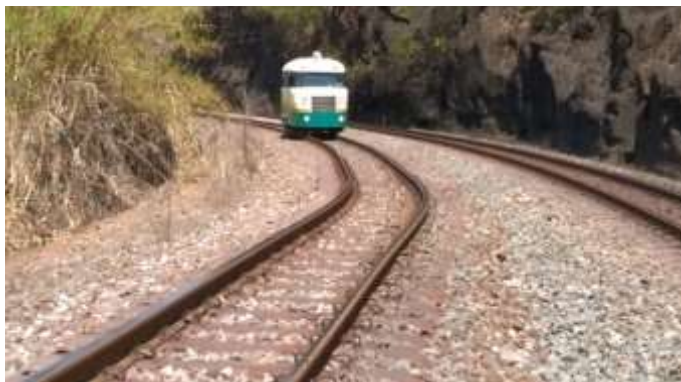
Fotografia 5 – Identificação de falha através da inspeção
