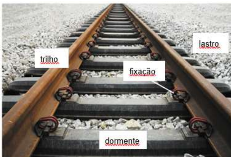
Figura 3 – Componentes da Superestrutura Ferroviária
