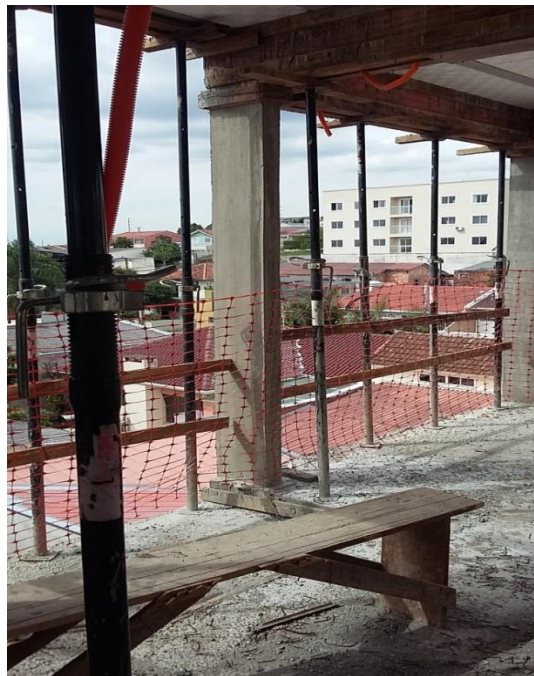
Fotografia 15 – Proteção de periferia
