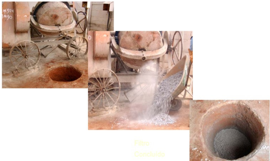
Figura 4 – Montagem e utilização do filtro de betoneira. Fonte: Dossiê Técnico, 2015
